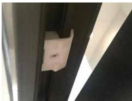
■ Houssette invisible permettant de maintenir le vantail semi-fixe
